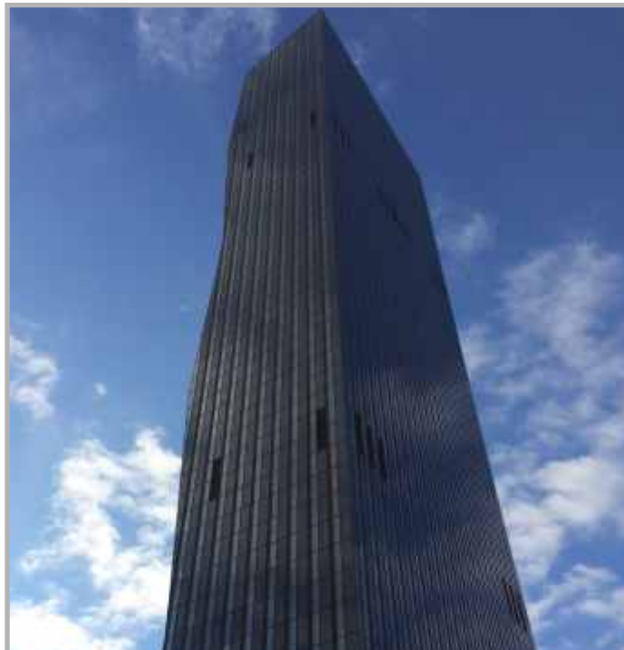
DC Towers (Wien, Austria)
